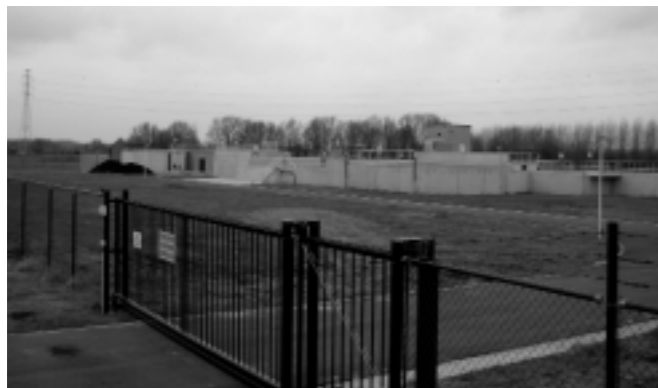
Nieuwe waterzuiveringsinstallatie in de Zeypestraat
