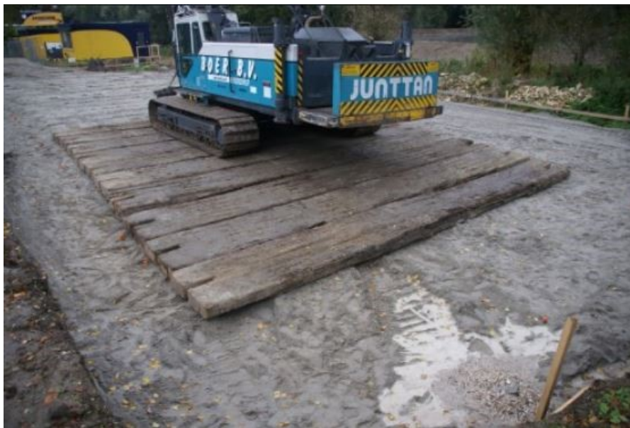
Afb. 12: Voorbeeld van het gebruik van draglineschotten bij werken op natte bodems.
