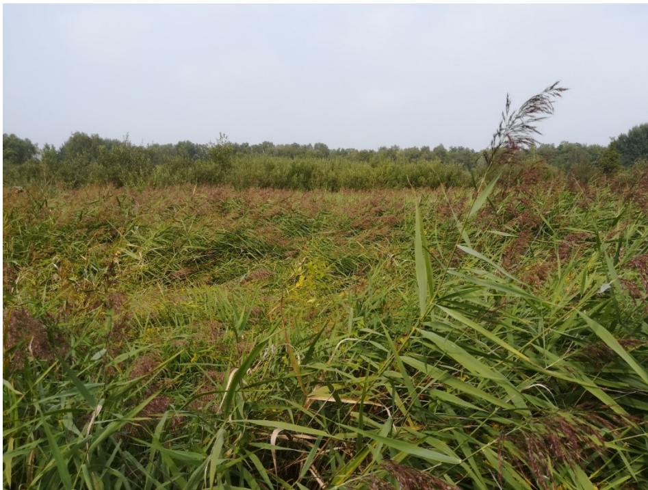
Afb. 3: Terreinfoto die de huidige situatie aangeeft van de rietzone op de dijk (05/09/2018)
