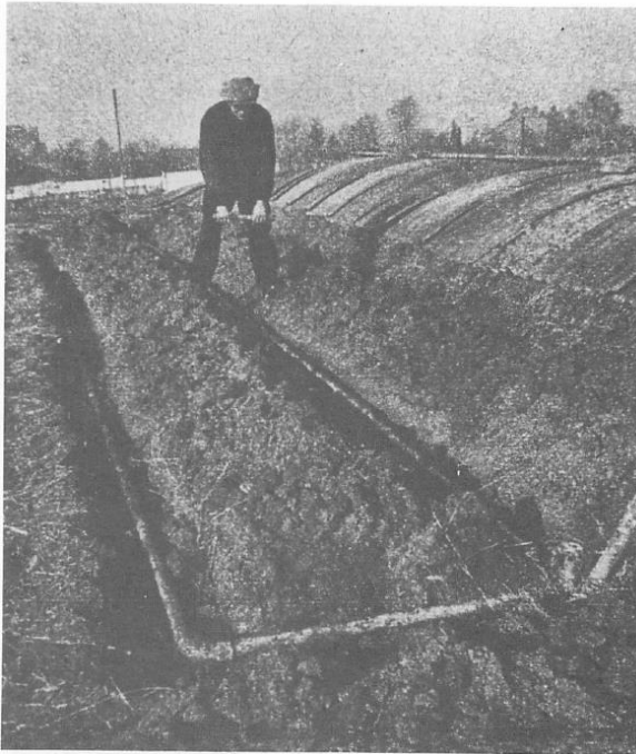
Figuur 12: Aanleg van kaders of metalen buizen ondergronds (Vanoppen 1974).
