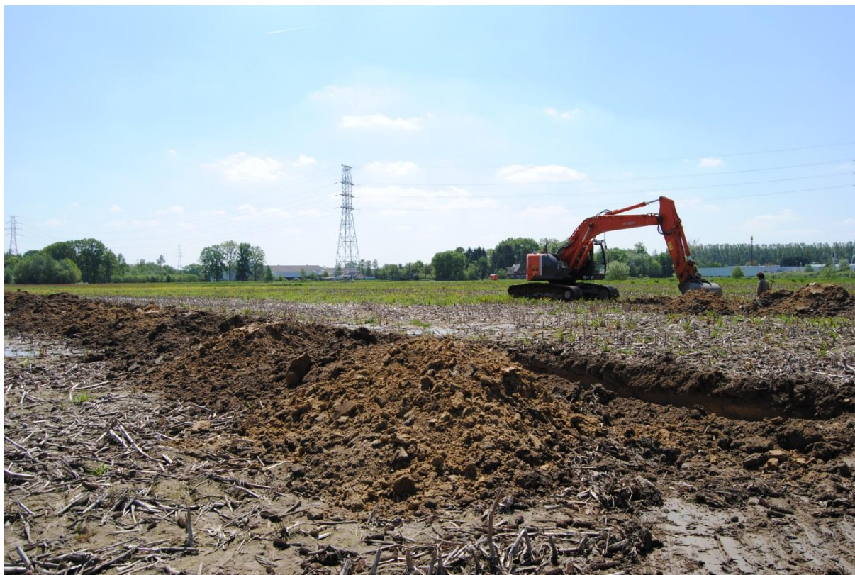
Fig. 14: De aanleg van de proefsleuven.
