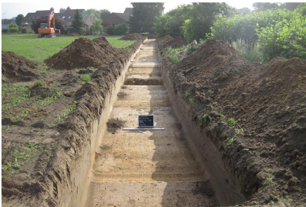
Fig. 9: Het graven van de proefsleuven.
