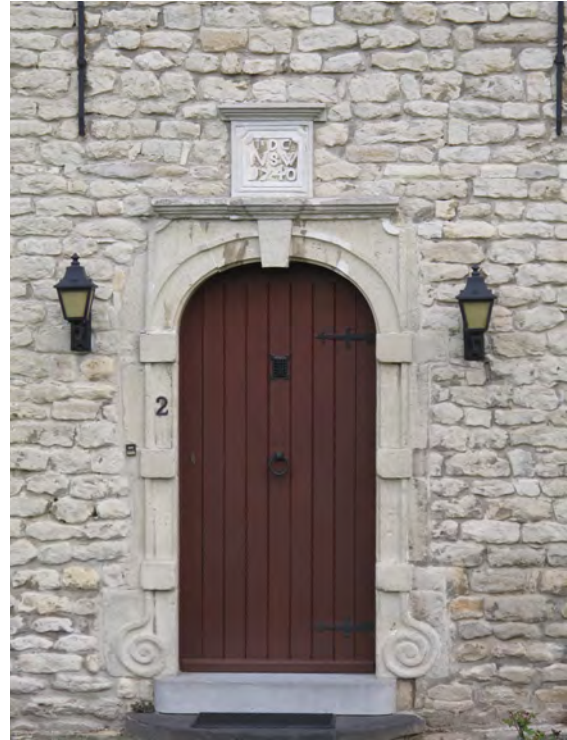
Figuur 14. Voordeur van de kasteelhoeve.
