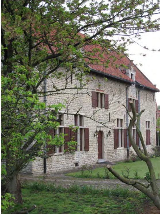
Figuur 13. De gerestaureerde vroegere kasteelhoeve bij het kasteel van Lelle.
