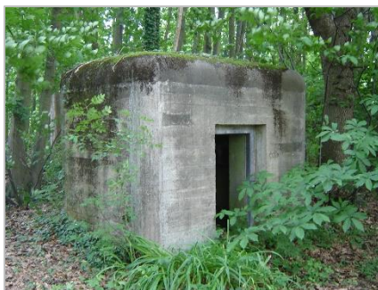
Figuur 24: Voorbeeld van een connectiekamer op de KW-linie (kwlinie.be) 8
