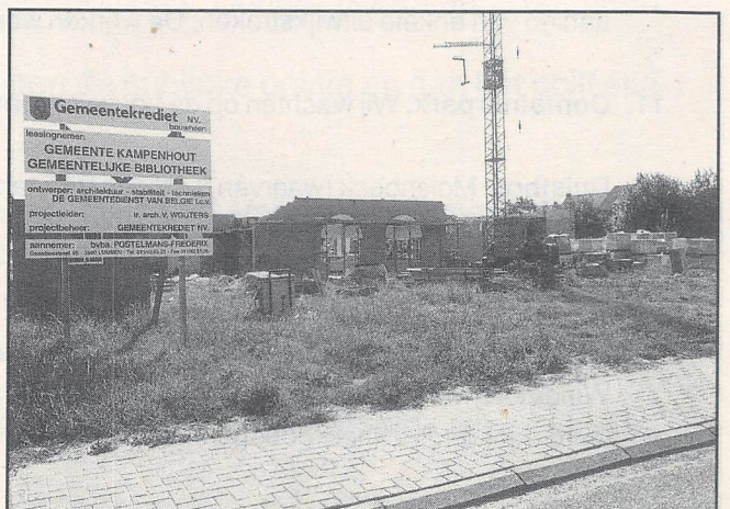
Bouw nieuwe bibliotheek
