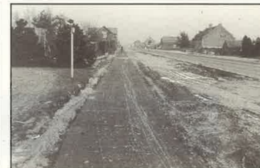
Fietspaden in aanleg langs Haachtsesteenweg
