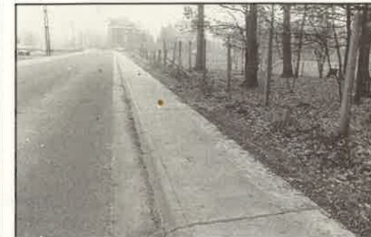
Opgekuist fietspad in de Voorstraat
