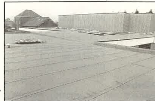
Vernieuwing dak schoolcomplex Berg
